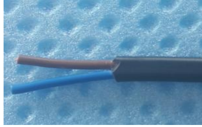
Şekil 4 :Kabloların dış koruması sıyrılır.
